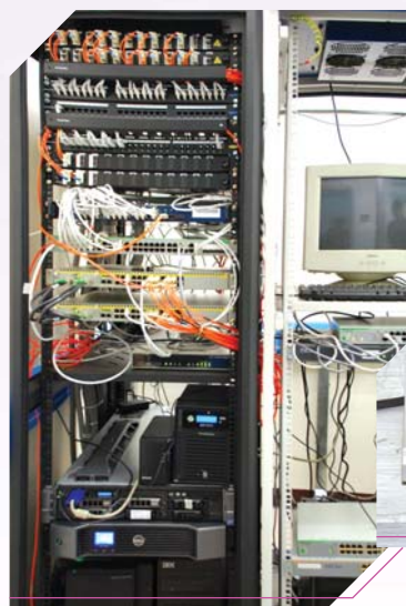
學校選用Allied Telesyn的光纖以太網核心交換機，作為校園網絡基建骨幹。
